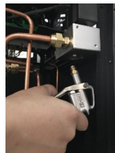
Rengøring før installation
